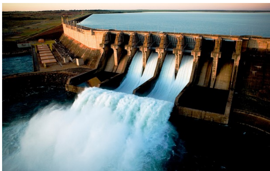
Figura 6 – Usina hidrelétrica de Água Vermelha
