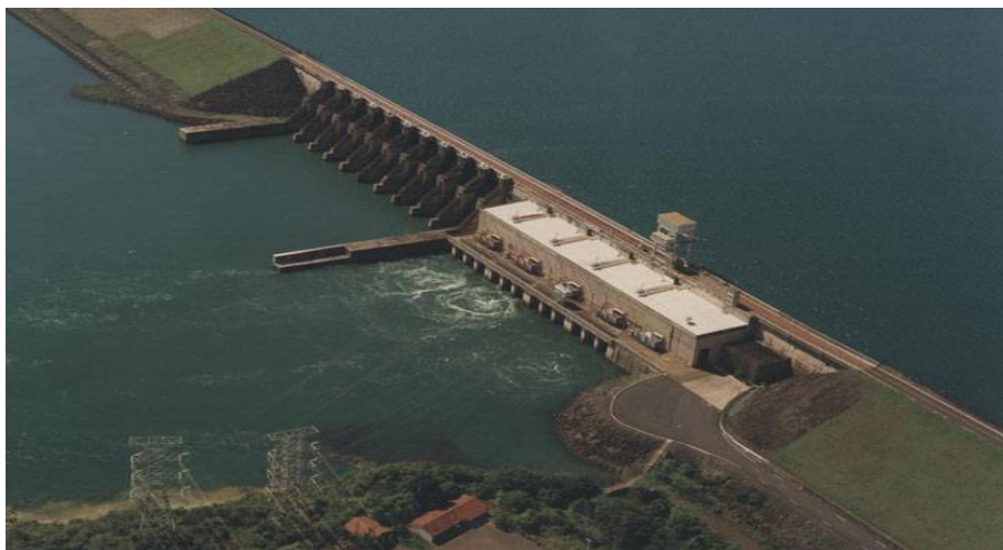
Figura 11 – Usina hidrelétrica de Volta Grande
