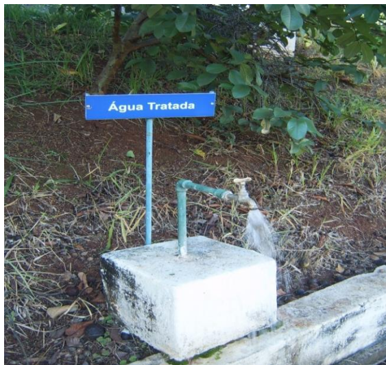
Figura 24 - Coleta na ETA
