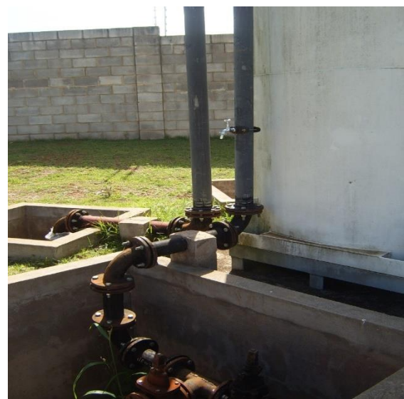
Figura 27 - Coleta no Reservatório
