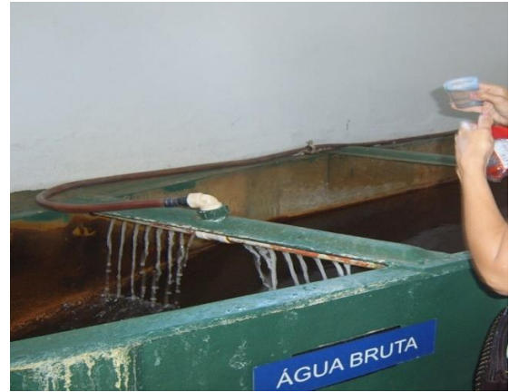
Figura 23 - Coleta na ETA
