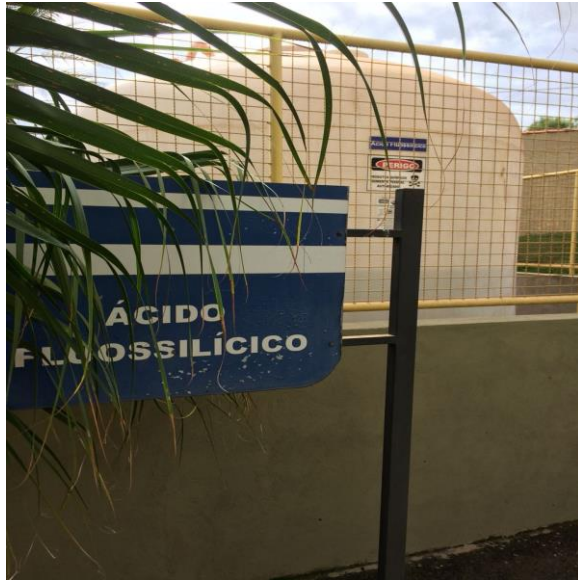
Figura 14 - Bomba dosadora de flúor
