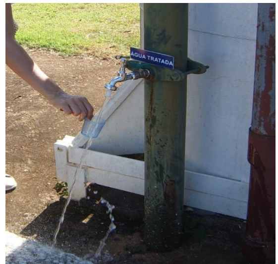
Figura 25 - Coleta no Reservatório
