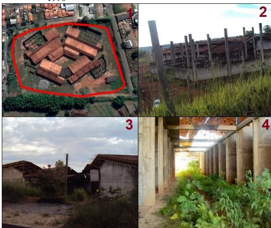
Figura 29 - Momentos de Construção do Antigo Shopping Center de Varginha na década de 1990
