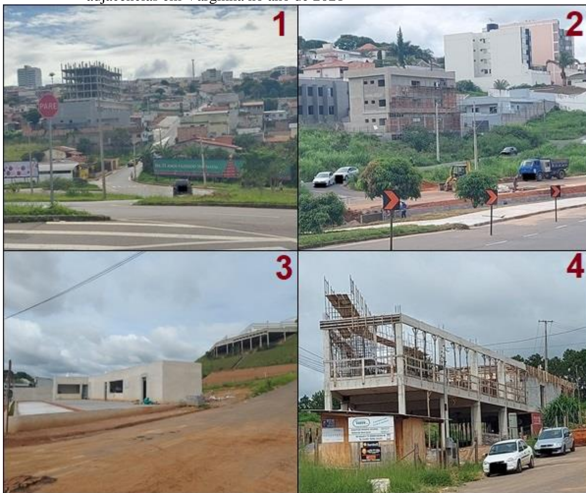
Figura 47 - Construções verticalizadas em andamento da Avenida Otávio de Carvalho e adjacências em Varginha no ano de 2021
