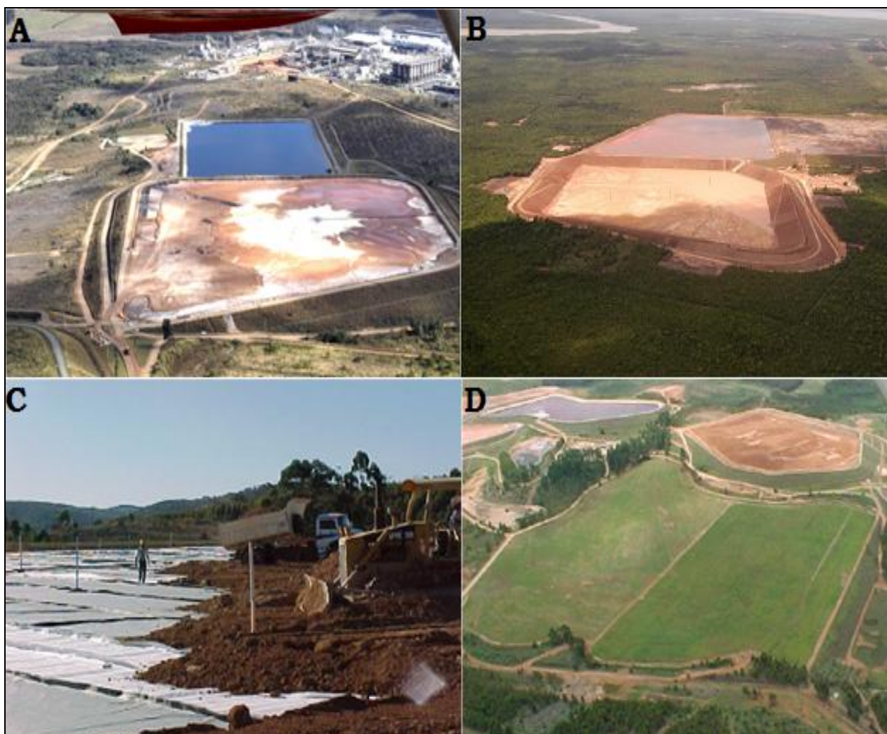
Figura 3 - Caracterização de locais típicos de áreas de disposição de resíduos de bauxita (ARB). Sendo (A) Vista aérea com água de reciclo; (B) Vista aérea; (C) Aplicação de manta geotêxtil para impermeabilização; e, (D) Vista aérea de área revegetada. Fonte: Costa Filho (2008).
