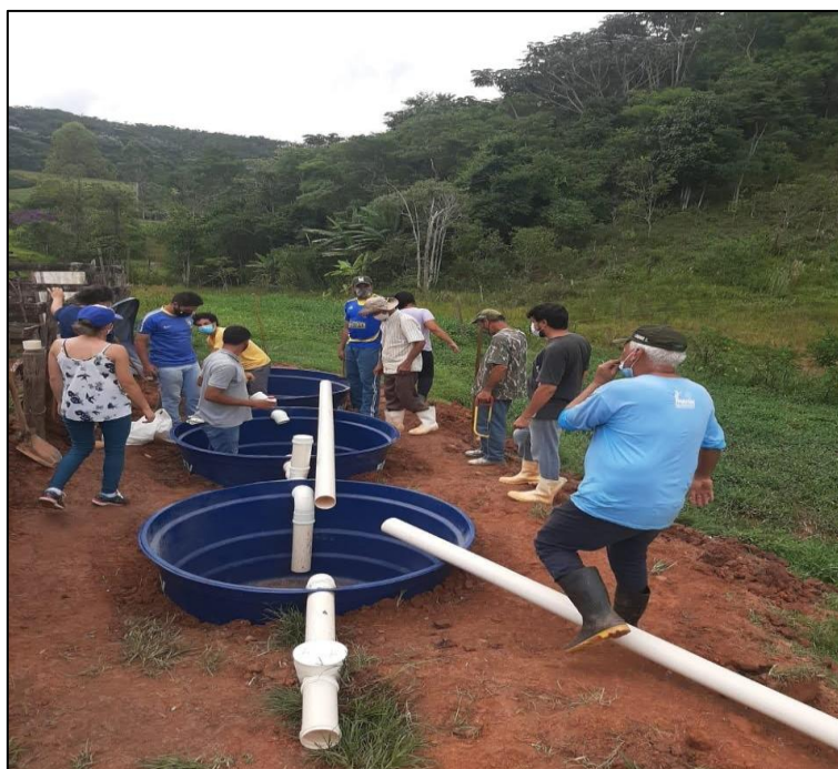
Figura 16 - Curso do SENAR sobre construção de fossa séptica biodigestor.
