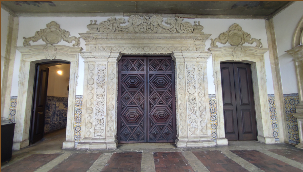
Fonte: Convento de Santo Antônio/Igreja de São Francisco.
