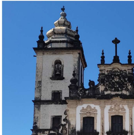
Figura 19 – Torre da Fachada.
