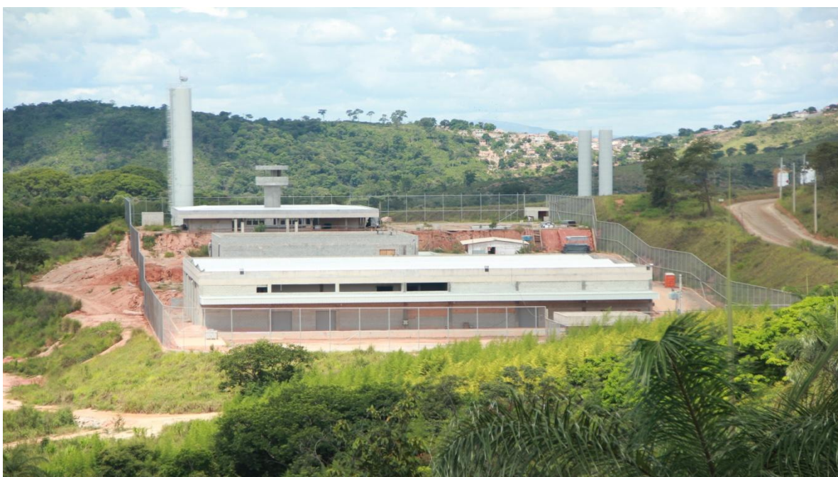
Fotografia 6 - Obras da Unidade Penal V do Complexo PPP. Fonte: Do autor.
