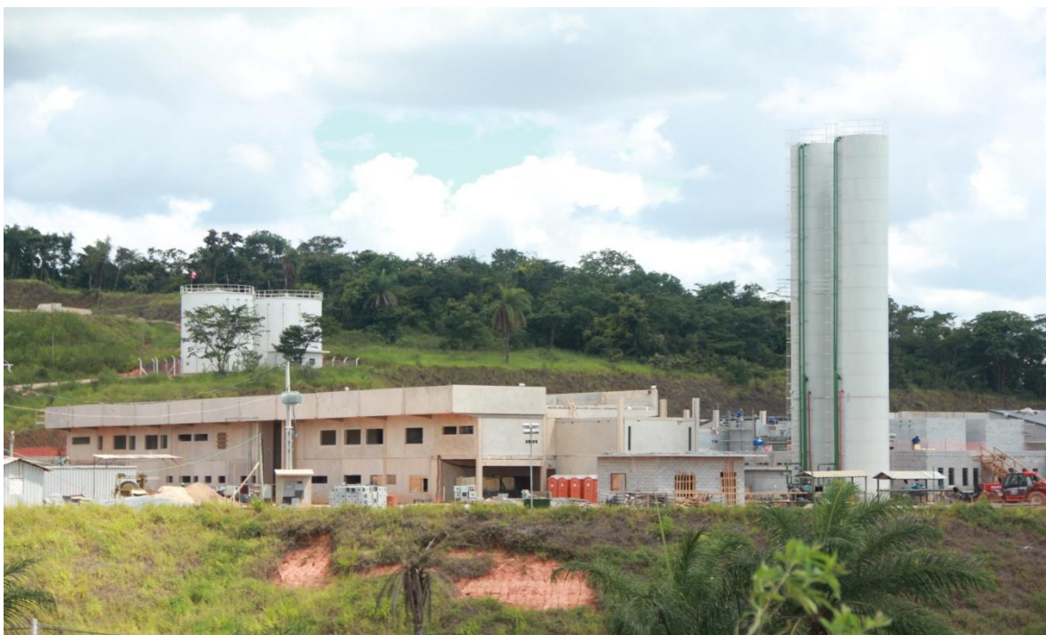
Fotografia 5 - Obras da Unidade Penal III do Complexo PPP. Fonte: Do autor.
